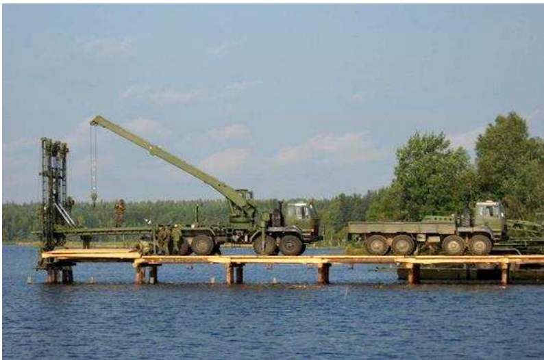
Рис. 1.155 – Мостобудівна установка УСМ-3
